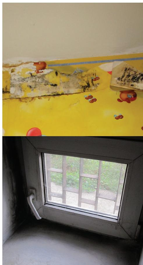
**Повышенная влажность** – проявления носят поначалу локальный характер, в основном в холодный период года на наружных ограждающих конструкциях:
