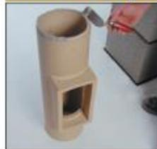
13. Перед началом монтажа всегда очищайте оба конца керамической трубы. Нанесите герметик или массу для заделки швов на нижнюю поверхность керамического тройника для подключения дверцы. Работы с герметиком вести только при температуре выше 5°C.
