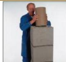
28. Установите внутрь и выровняйте керамическую трубу, удалите избыток массы для заделки швов и заглайте шов губкой. Повторите все монтажные операции в последовательности, изображенной на рис. 25-28, до устья дымовой трубы.
