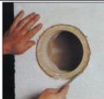
32. При проведении отделочных работ еще до затвердевания штукатурки сделайте разделительную канавку между керамическим элементом дымовой трубы и штукатуркой.
