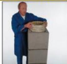
26. Изоляционные плиты сорвите, вставьте внутрь каменной облицовки и вместе опустите вниз. Изоляционные панели устанавливайте всегда до монтажа внутренних керамических элементов.
