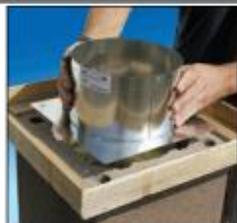
50. Кровельную плиту можно отливать по месту в заранее подготовленной опалубке на строительной площадке или непосредственно на дымоходе. Для монтажа используют бетон марки М300. Перед отливкой плиты необходимо установить манжету и закрыть сечение дымохода от попадания бетонного раствора.
