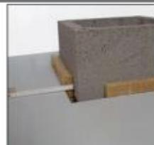
35. При монтаже дымохода через перекрытие подготовьте отверстие в конструкции на 5 см больше, чем наружный размер каменной облицовки дымохода. Этот промежуток заполните негорючим изоляционным материалом.
