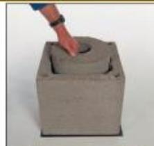
3. Установите бетонный блок-основание или залейте бетоном внутреннюю обложку каменной оболочки. Работы с бетонной смесью вести только при температурах выше 0°C.
