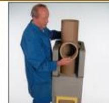
20. Установите внутрь тройник для подключения потребителя. Выступ на верхней грани керамической трубы должен всегда находиться снаружи, канавка внутри. Ориентация т.н. «по водам устанавливать для всех видов топлива».
