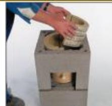
7. Следите за тем, чтобы изоляционный материал не засорял каналы вентиляции дымохода. Трубопровод для отвода конденсата выведете в отверстие вентиляционной решетки, а затем подключите к системе канализации.
