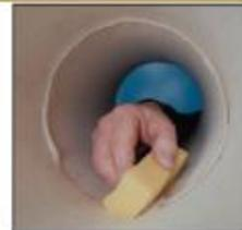
15. Избыточный герметик или массу для заделки швов после установки керамических элементов всегда удалите влажной губкой, а швы внутри равняйте так, чтобы внутренняя поверхность была гладкой, а шов полностью залочен. Ровное и гладкое внутреннее сечение обеспечивает требуемую тягу.
