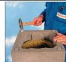
39. При монтаже готовой покровной плиты установите добор в отверстие верхней каменной облицовки.
