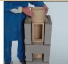
14. Установите тройник для подключения дверцы таким образом, чтобы стенки тройника располагались параллельно стенкам каменной оболочки и на одинаковом расстоянии 3 см от них. Выступ на верхней грани керамической трубы должен всегда находиться снаружи, канавка внутри. Ориентация т.ч. его всегда действует для всех видов топлива.
