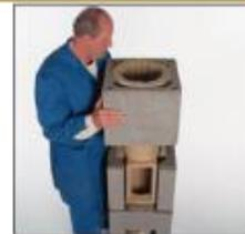
16. Вставьте два изоляционных элемента внутрь каменной оболочки вместе с изоляцией на подготовленный цементный раствор. Блок постоянно выравнивайте по уровню.
