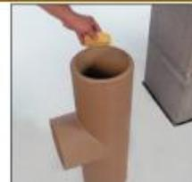
18. Сместите нижнюю грань тройника для подключения потребителя и в случае использования сухой смеси для заделки швов нанесите заделку швов. При использовании герметиков в трубе, нанесите их непосредственно в канавку верхнего края внутренней керамической трубы без предварительного смачивания керамического элемента.
