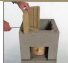
6. Согните изоляционную панель прорезями внутрь и вставьте в каменный блок так, чтобы соединение двух элементов изоляции находилось посередине задней стенки. Излишки изоляции обрежьте специальной пилой, входящей в «Основной комплект».
