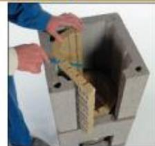
10. Блок установите на раствор, излишки раствора удалите. Изоляционные панели прорезями внутрь вставьте в каменный блок так, чтобы соединение двух элементов изоляции находилось посередине задней стенки. При помощи пилки отрежьте излишки изоляционного материала вдоль каналов проветривания дымохода. Внимание: канальное проветривание должно быть свободным!
