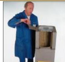
17. Блок с вырезанным отверстием установите на подготовленный раствор, излишки раствора удалите. Изоляционные панели прорезаны внутри вставьте в каменный блок. При помощи пилы отрежьте излишки изоляционного материала вдоль каналов проветривания дымохода. На верхнюю грань каменной облицовки нанесите необходимое количество раствора, используя монтажный шаблон.
