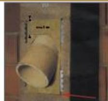
24. При использовании твёрдого топлива применяйте керамический элемент для подключения дымового канала под углом 45°. Для его установки вырежьте при необходимости два блока. По всему диаметру керамического элемента всегда должен сохраниться промежуток между блоком и керамическим элементом по сторонам минимум в 1 см, сверху и снизу не менее 3 см.
