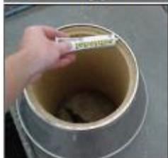
49. Шов между внутренней керамической трубой и конусом уплотните специальным силиконовым герметиком Hetsesil.
