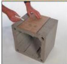
9. На следующем блоке начертите контур отверстия для дверцы, размеры которого уточните по прилагаемой таблице, входящей в состав «Основного комплекта». Угловой шлифовальной машинкой вырежьте отверстие.
