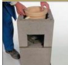
5. Блок установите на раствор марки М150 на подготовленном цоколе. Выровняйте при помощи уровня. Для удобства эксплуатации разместите отверстие для подачи воздуха, а также дверцы для очистки дымохода под углом 90° к оси подключаемого потребителя. Установите емкость для сбора и отвода конденсата в центре блока на цементный раствор.
